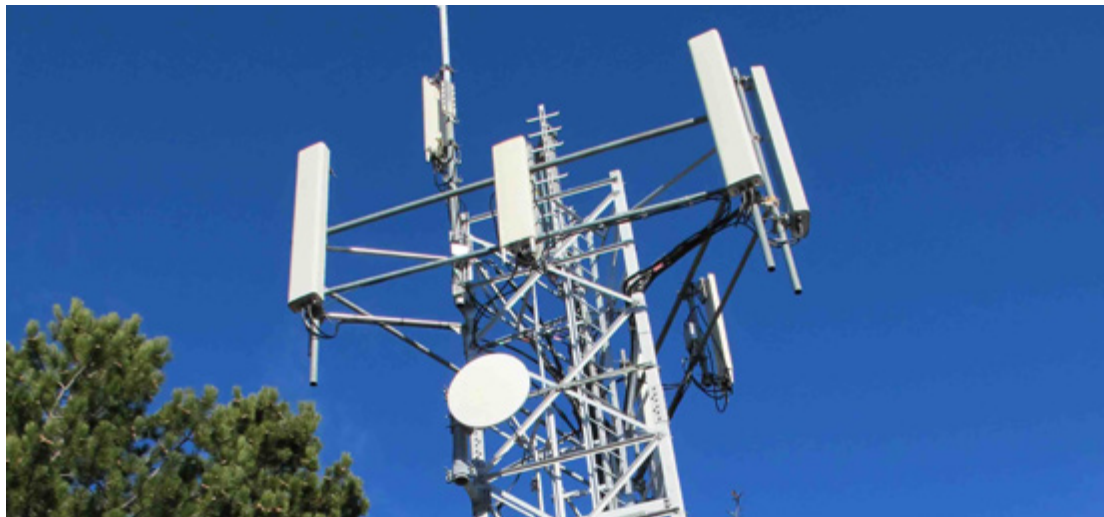
Station avec antennes 4G
