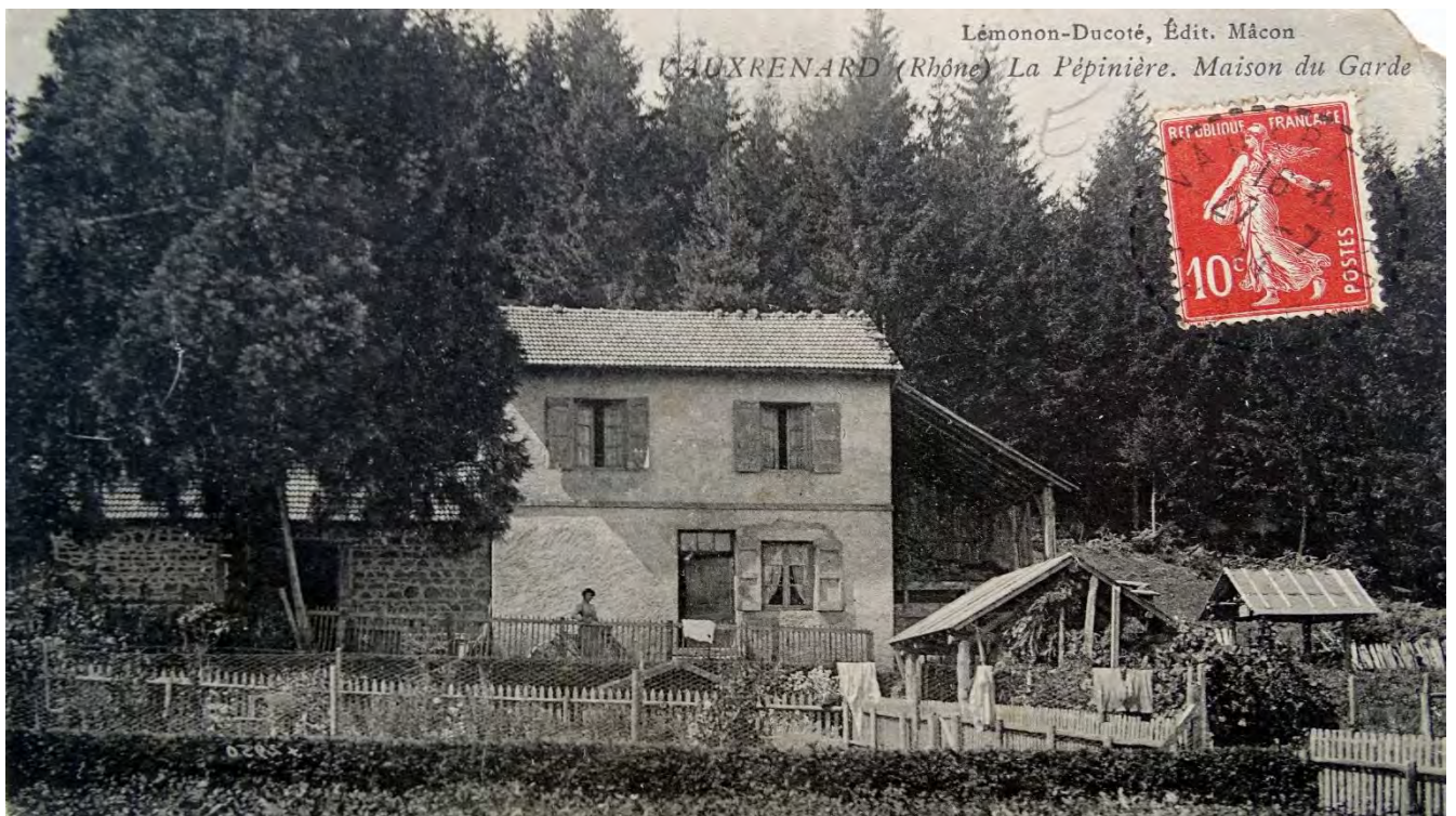
Maison départementale de la pépinière aux environs de 1900
